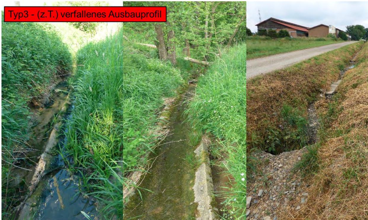
**Abbildung 18: Gewässertyp 3 mit unterspülter oder schon aufgelöster Betonhalbschale (IfaS 2015).**
